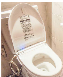
【トイレの洋式化改修】
